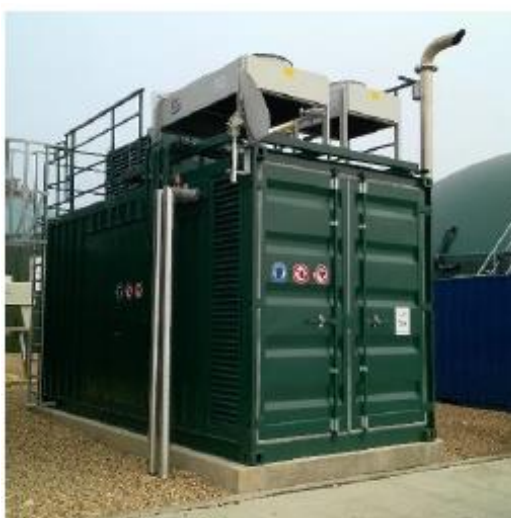
Rysunek 15 Jedna jednostka kogeneracji w zabudowie kontenerowej
