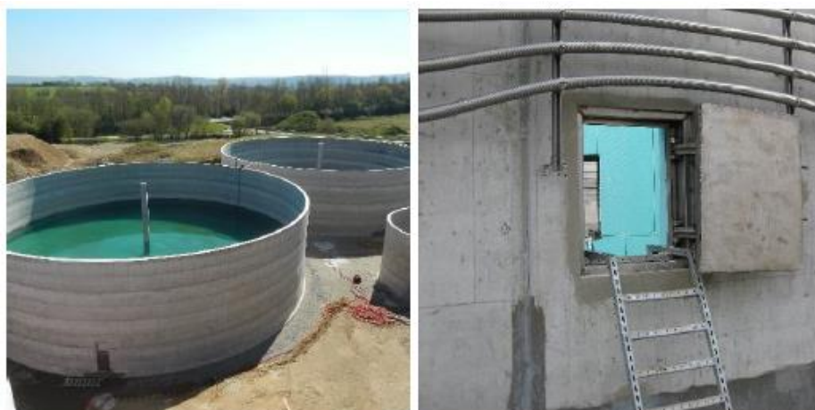
Rysunek 11 Żelbetowy zbiorniki nieuzbrojone w trakcie budowy (rysunek z lewej); właz technologiczny z systemem grzewczym zbiornika fermentacyjnego żelbetowego (rysunek z prawej).
