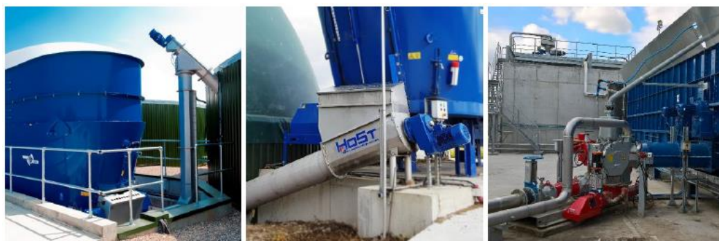
Rysunek 10 Integracja zasobnika substratów sypkich z komorą fermentacyjną
